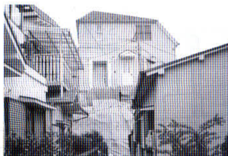
写真-1 事例1の施工前
