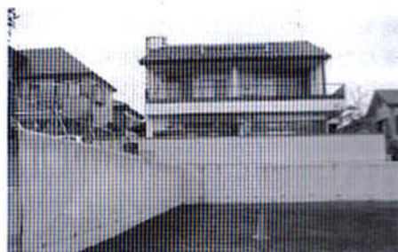
写真-4 事例2の施工後
