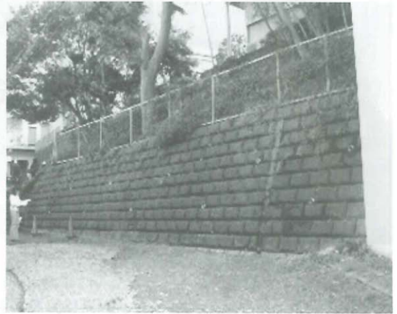
写真-3 事例-2 施工前
