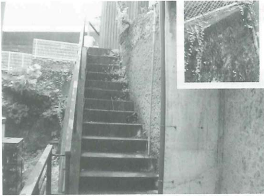
写真-1 事例-1 施工前 (ガンタ積擁壁)
