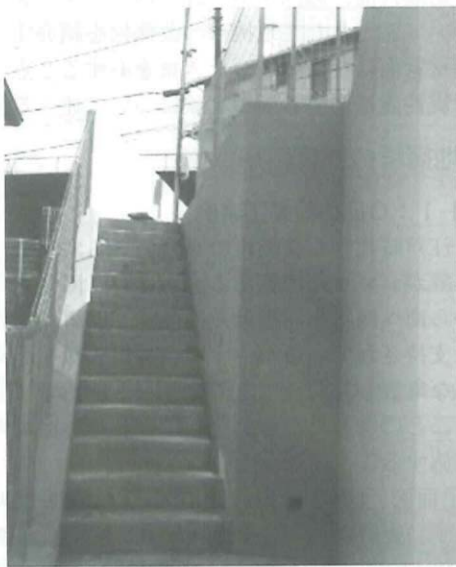
写真-2 事例-1 施工後
