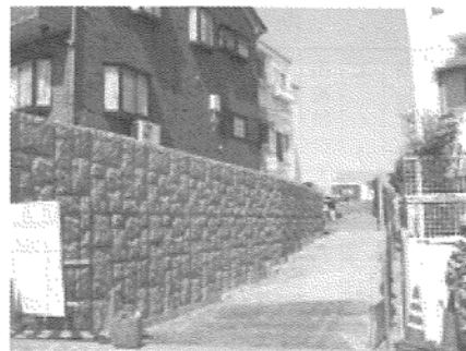
写真-3 完成状況
