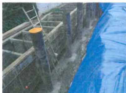
鋼管杭打設状況
