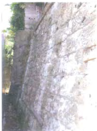
擁壁診断事例：大谷石擁壁
