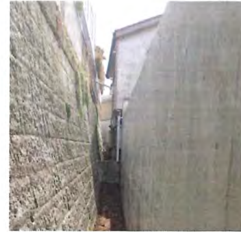
隣地既存擁壁(大谷石)と防護壁
