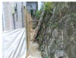
ガンタ石積み擁壁
