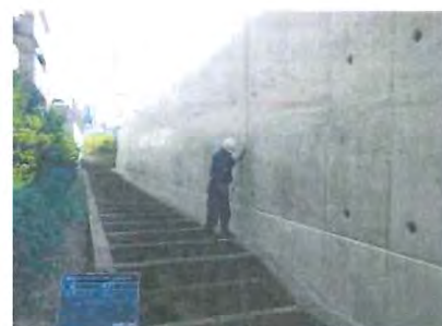
擁壁前面水路側
