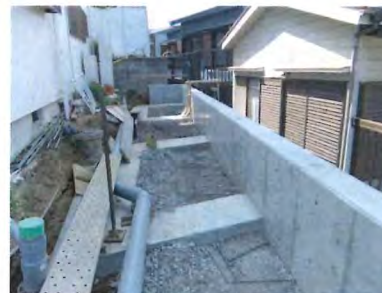
擁壁前面壁とつなぎ梁の状況
