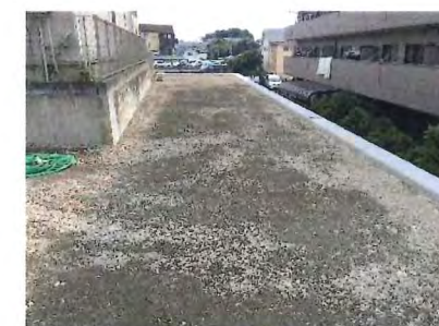
造成後の宅地(擁壁上面)
