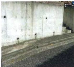
適正な水抜き穴
