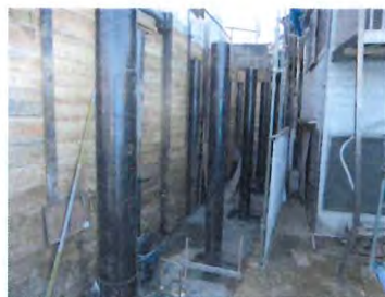
杭の打設状況
