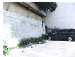
張出し床版付擁壁
