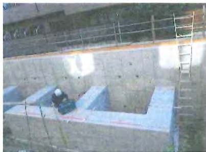
土圧壁とRC梁の打設後
