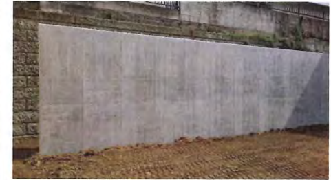
防護壁築造後
