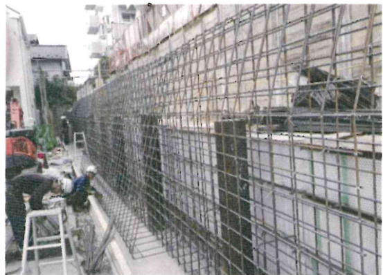
写真-2 鋼管杭打設後
