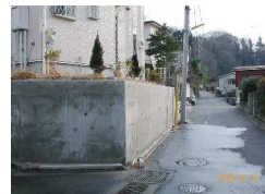
全体を壊さず下部の玉石一部を解体し、KDパイルを用いた自立型擁壁を築造
